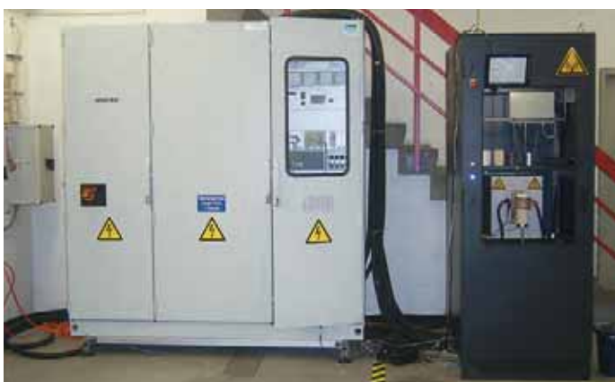
Bild 1: Versuchsanlage zur Induktionserwärmung
